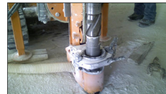
Perforazione con utilizzo di centratori (opzionale) Drilling with rod guides (optional)
